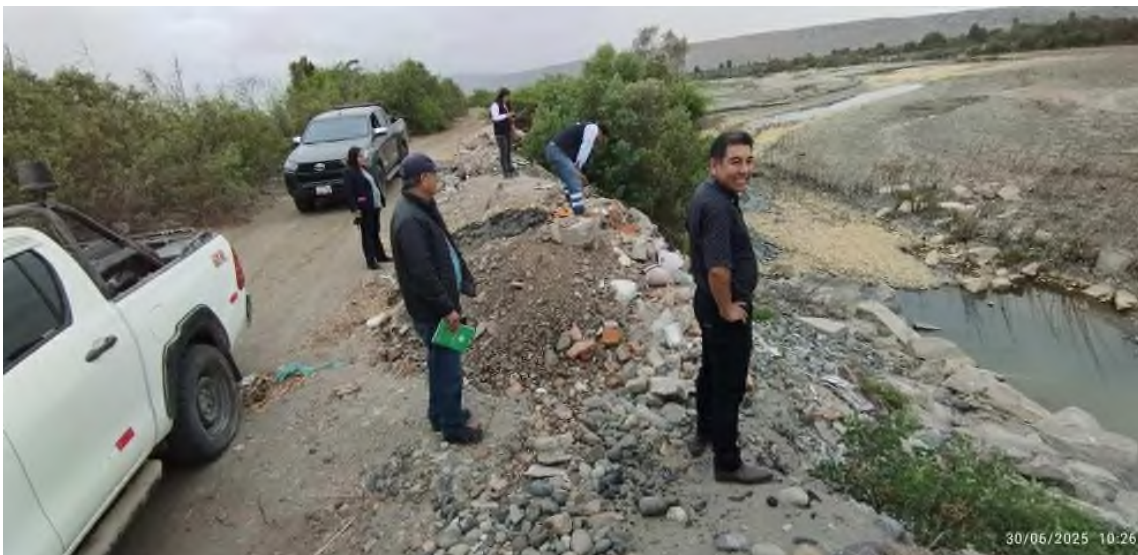
FIGURA N°03: TRAMO 06 PUNTO FINAL DE ACTIVIDADES DE ENROCADO EN TALUD DE DIQUE MARGEN DERECHA RIO TAMBO, DIQUE SIN ENROCADO DE PROTECCION
