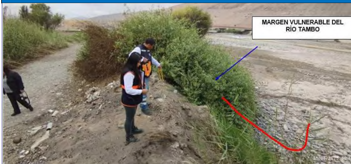
FIGURA N°01: TRAMO 01 INICIO DE ACTIVIDADES, TRAMO DE DIQUE SIN ENROCADO DE PROTECCION, TRAMO INICIA AGUAS ABAJO DE PUENTE FREYRE MARGEN DERECHA DE RIO TAMBO
